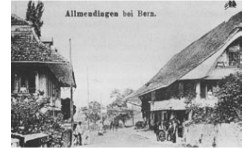
Strasse beim „Hirschen“ vor dem Ausbau
