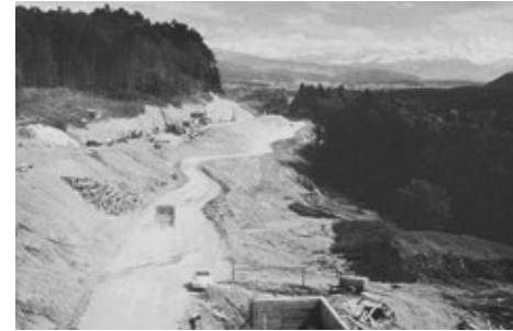
Autobahnbaustelle am Raintalhang 1971/72
